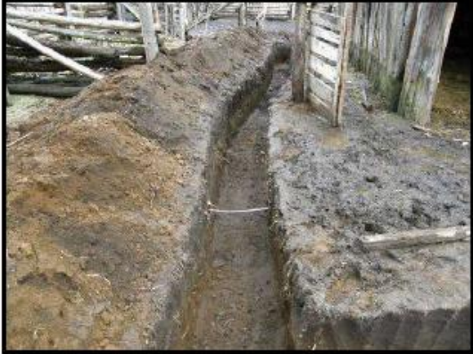
Foto 3: Zanja de 60 cm de ancho por 80 de profundidad rodeando el galpon. (Foto C. Nuñez).
