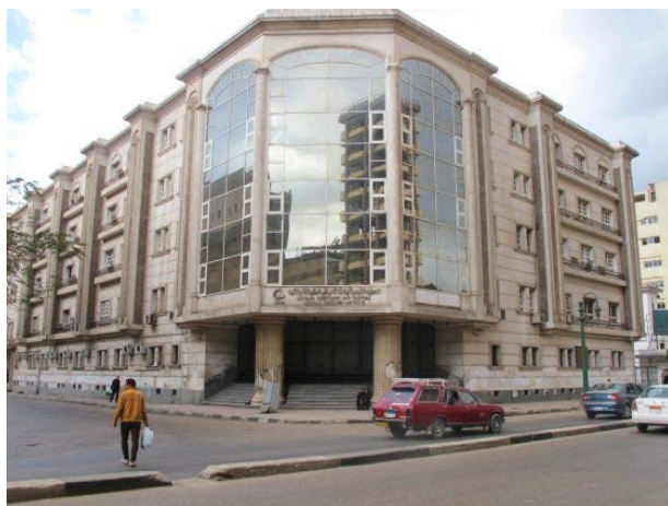
Hospital en El Cairo.
