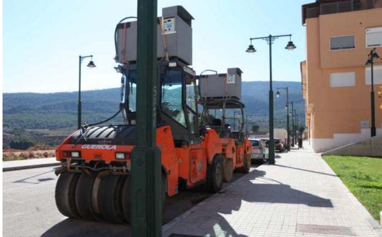
Las máquinas de asfaltado están paradas en Batoy y presentan el característico depósito en el techo para usar agua tratada.
