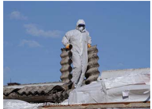
Los trabajos en edificios contaminados con asbesto se realizan bajo altas medidas de seguridad.
