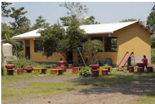
La escuela del cantón San José está ubicada en San Lorenzo, Suchitepéquez.
